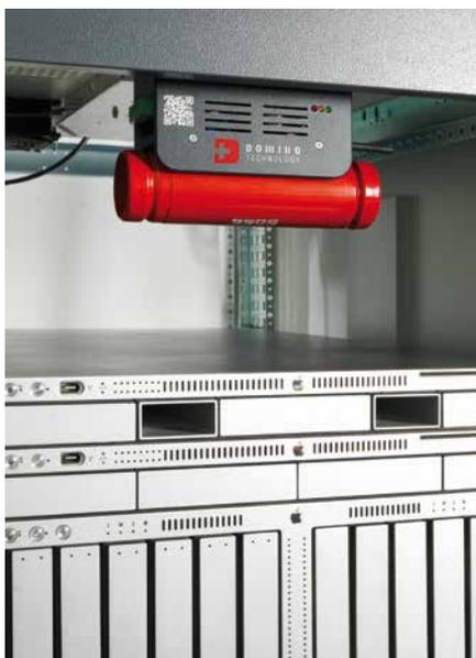
**ACTIVA®** monitora continuamente sia i livelli di monossido di carbonio che la temperatura assoluta e differenziale all'interno del quadro elettrico. Non appena viene registrato un aumento delle concentrazioni di monossido e/o della temperatura in un range critico, viene generato un allarme.
